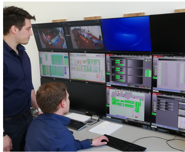
An einem Leitstand pro Standort werden auf mehreren Bildschirmen alle Betriebszustände übersichtlich dargestellt.
