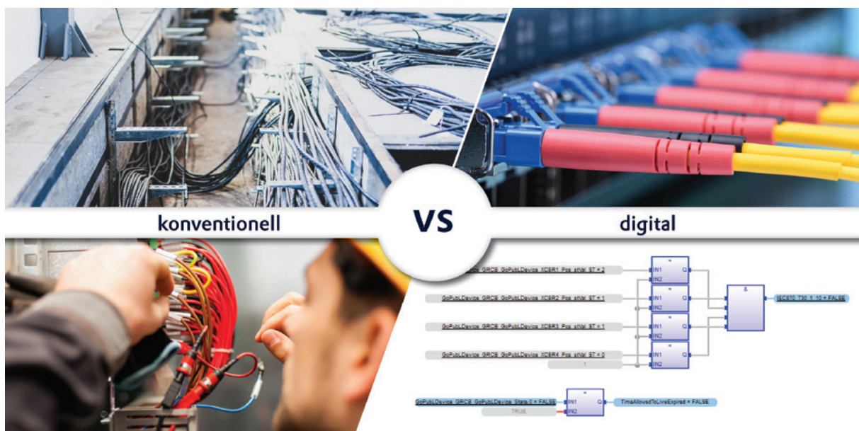
Bei der Digitalisierung anhand von IEC 61850 wird kostenintensive Verkabelung durch flexible Netzwerkkommunikation ersetzt. Signalverbindungen zwischen Geräten werden mit smarten Softwaretools konfiguriert.
