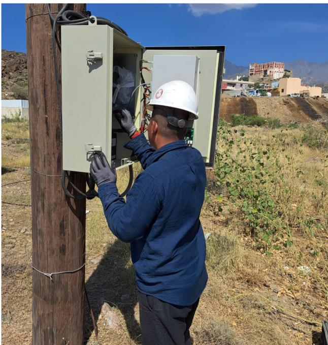
*Um die Wartung der Netzanlagen entlang der Freileitungen einfacher und weniger zeitaufwändig zu gestalten, vernetzte Al-Ojaimi die Geräte über das öffentliche Mobilfunknetz mit den Leitständen.*
