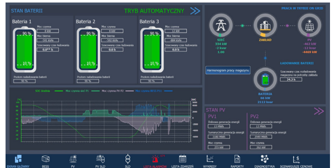
Uno screenshot della schermata dell'operatore EMS mostra lo stato operativo dell'impianto di stoccaggio e del parco fotovoltaico.
